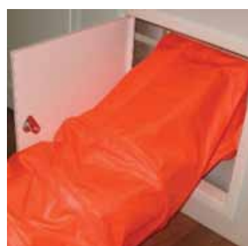
Удаление через шахту ДУ
