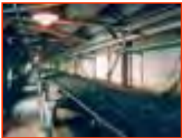
Конвейерные транспортёры, элеваторы
